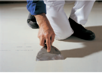
Plattenstöße mit Knauf Uniflott/TRIAS schließen
