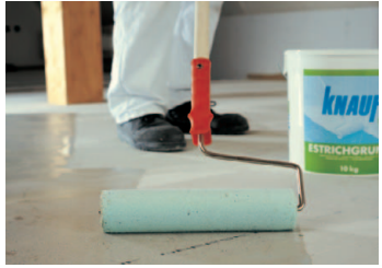
Die Oberfläche wird mit Knauf Estrichgrund (1:1 mit Wasser verdünnt) grundiert
