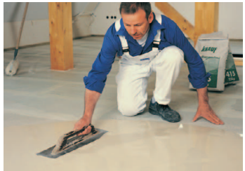
Die fließfähige Spachtel wird mit Traufel oder Zahnrakel auf ein gleichmäßiges Niveau gezogen
