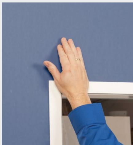
Abdeckrahmen einsetzen
