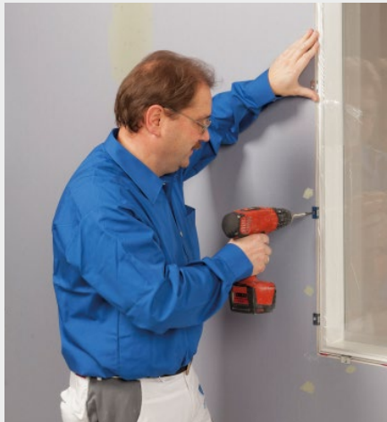
Fertigfenster verschrauben
