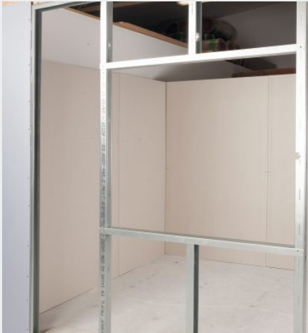
Öffnung für Fertigfenster herstellen
