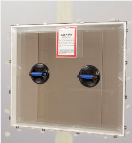
Fertigfenster einsetzen
