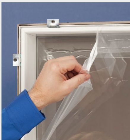
Schutzfolie entfernen
