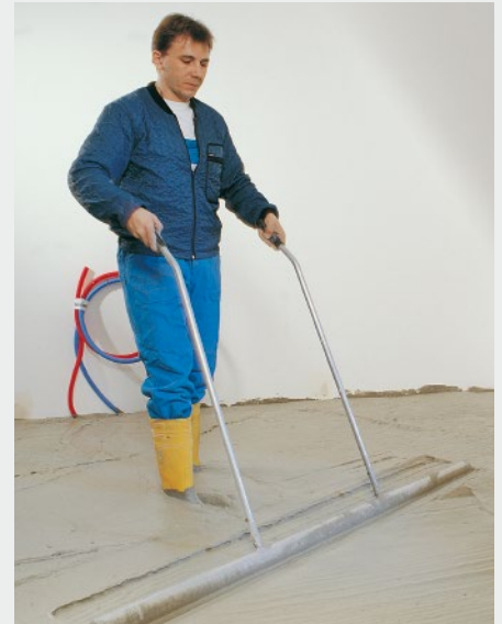
Nach Einbringen des Materials einfach mit der Schwabbelstange einebnen
