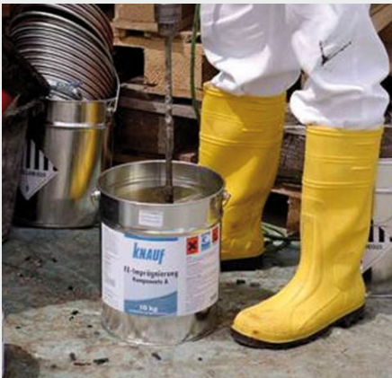
Anmischen des Epoxidharzes mit dem Rührgerät
