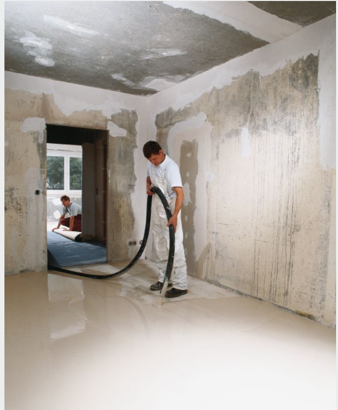
z. B. maschineller Einbau Knauf Nivellierestrich 425
