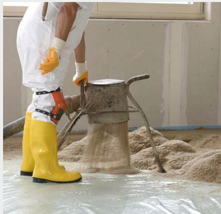
Einbringen mit Druckluftförderer
