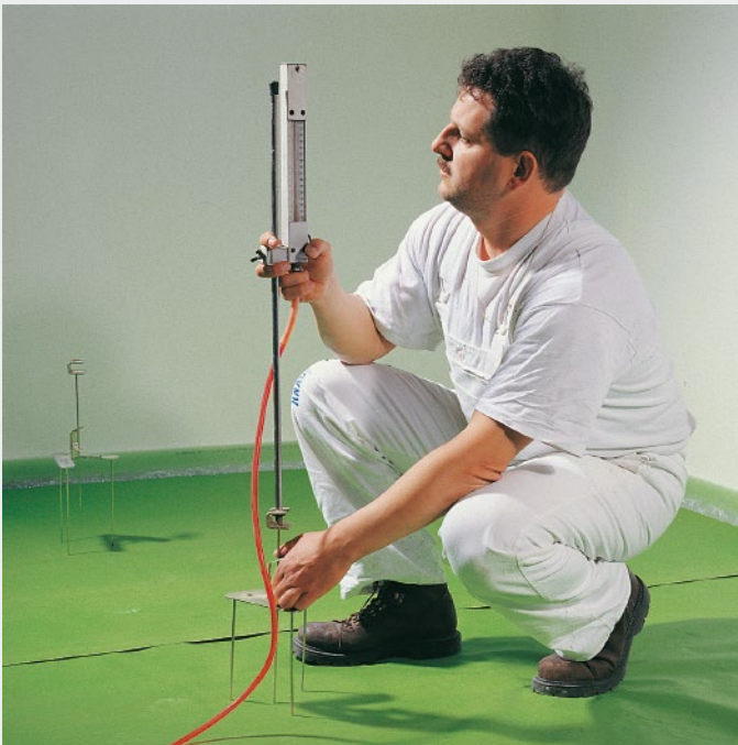
Einstellen der Höhe mit PFT Nivelliertaster
