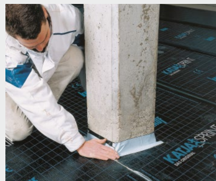
Anschlüsse an aufgehende Bauteile mit Knauf Anschlussstreifen
