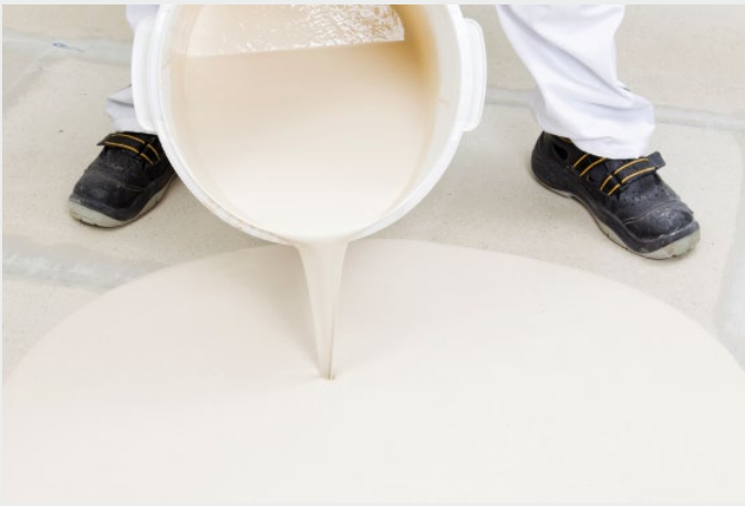
Spachteln des Estrichs mit Knauf Nivellierspachtel 415
