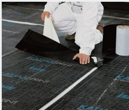
Abdichten von Kopfstößen mit Knauf Anschlussstreifen
