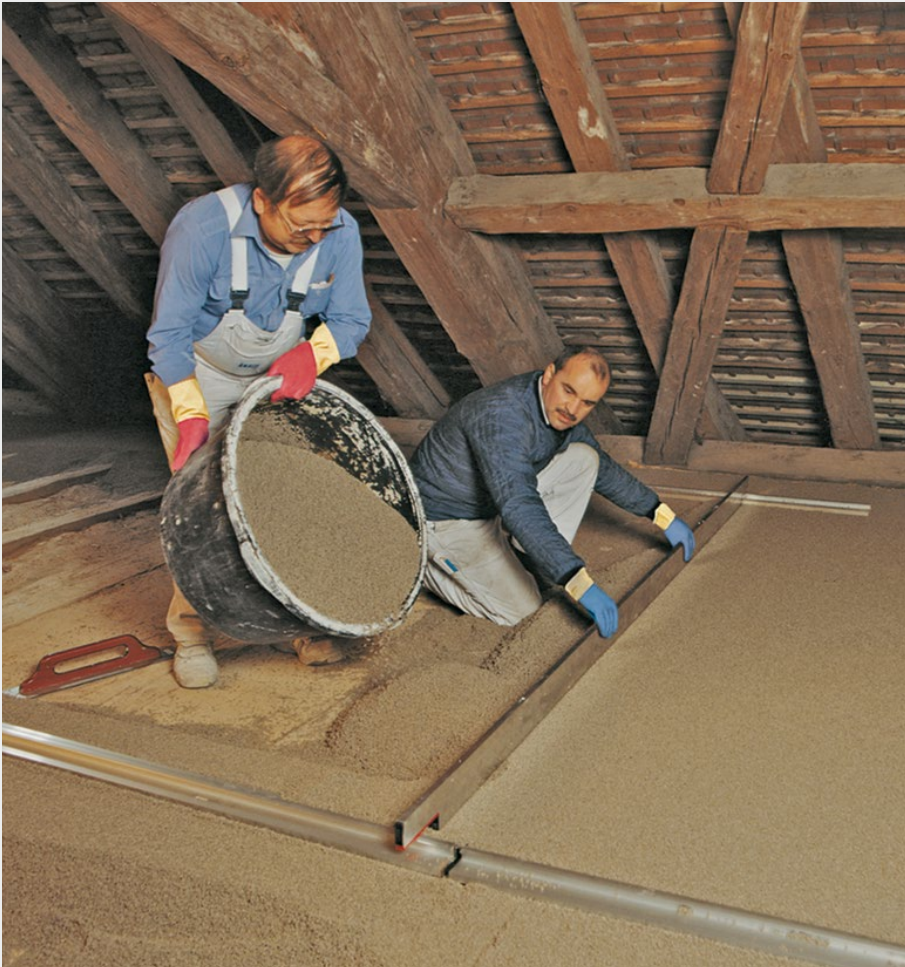
Ideal auf alten Holzbalkendecken: Knauf EPO-Leicht.
