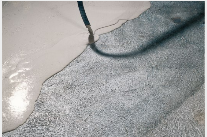
Maschineller Einbau Knauf Nivellierspachtel 415
