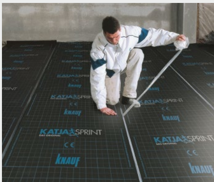
Schließen der Längsstöße durch Abziehen beider Folienstreifen
