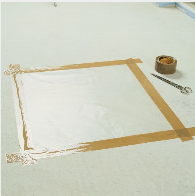
Vorprüfung der Trocknung mit Folie auf Heizestrich
