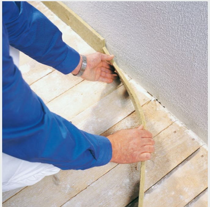
Verlegung Mineralwolle-Randdämmstreifen bei Anforderungen an den Brandschutz
