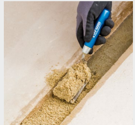
Ideal für schnelle Reparaturarbeiten: Knauf Stretto nach einem Tag belegreif
