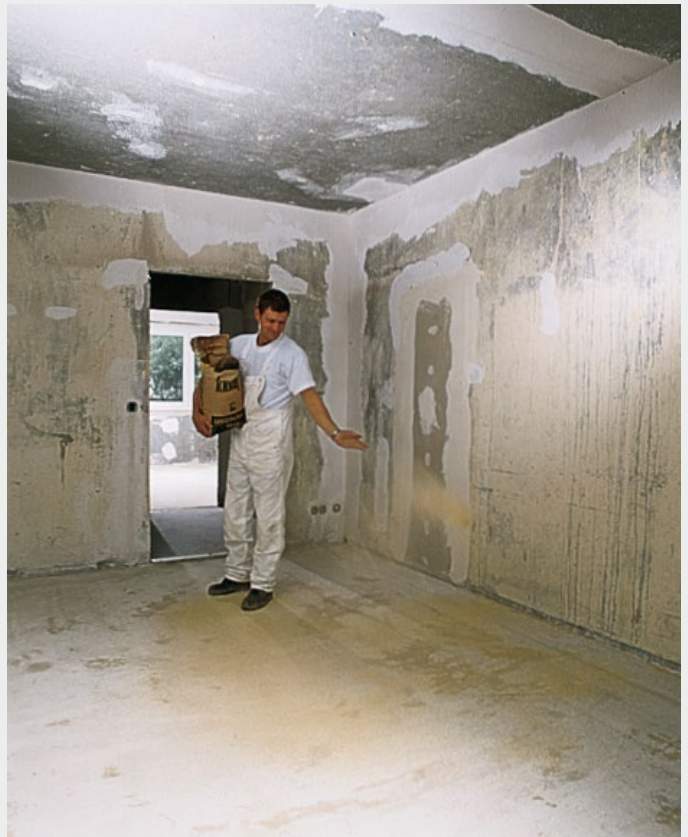
z. B. Haftbrücke mit Quarzsandeinstreuung
