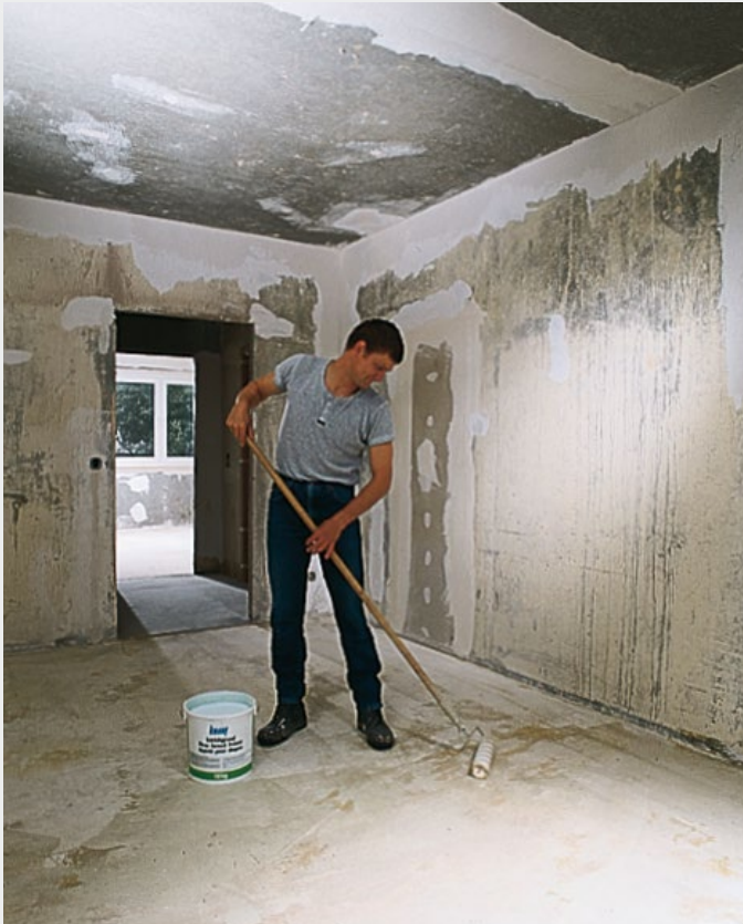
z. B. Grundierung mit Estrichgrund
