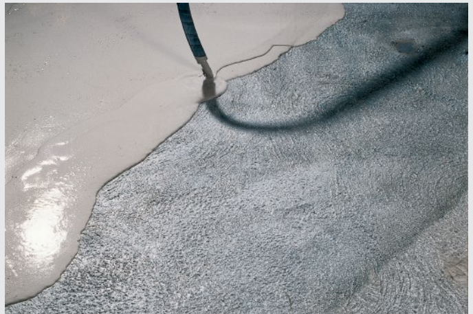
Machine application of Knauf Nivellierspachtel 415
